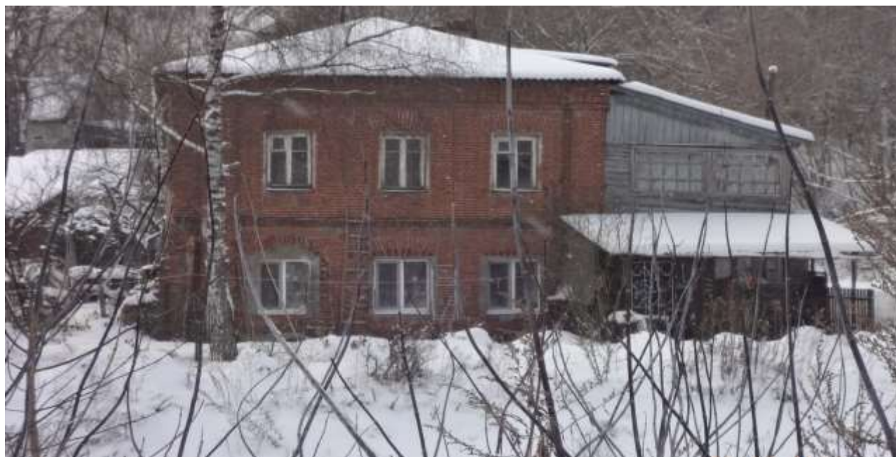
ул. Пески, дом № 5
